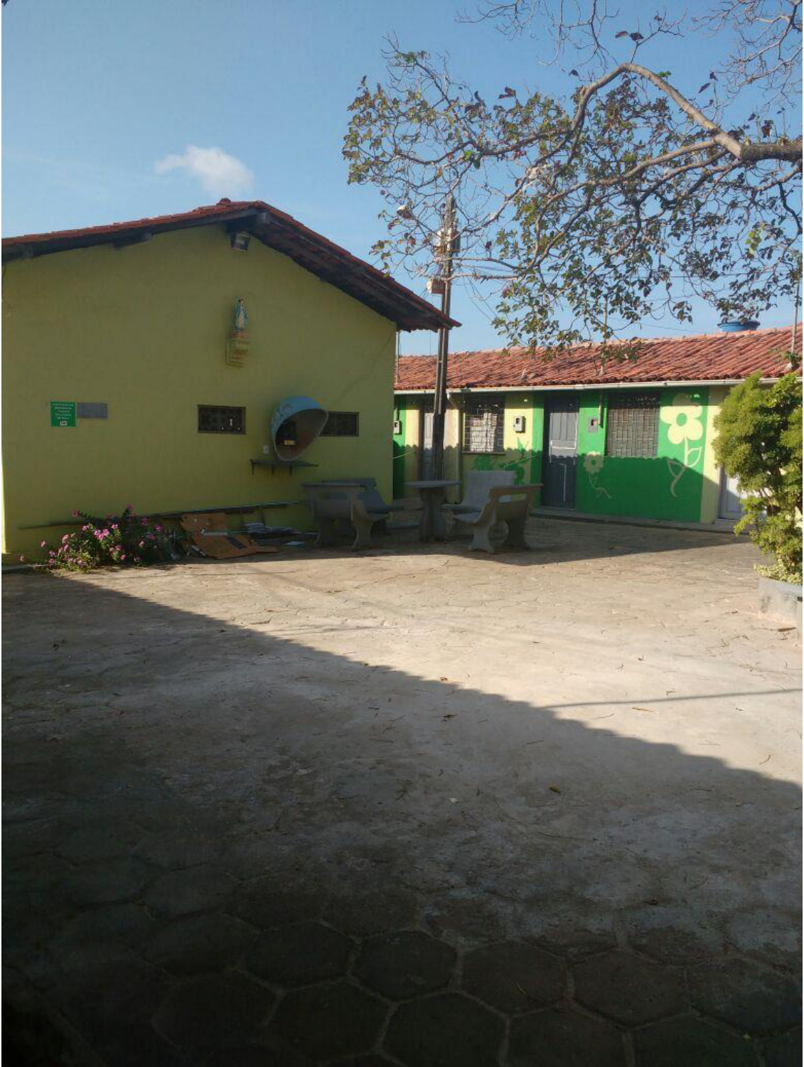
Imagem 5 – Bancos de cimento e orelhão localizados na parte de trás do Abrigo. Fonte: Carla Alves (2017).
