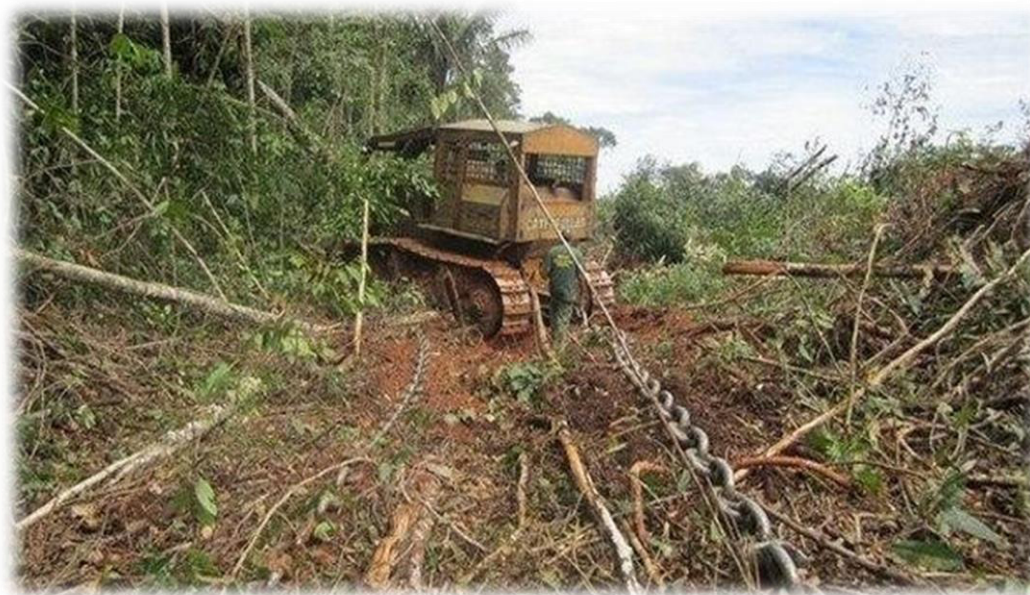
Figura 5: Derrubada de matas com uso de correntão
