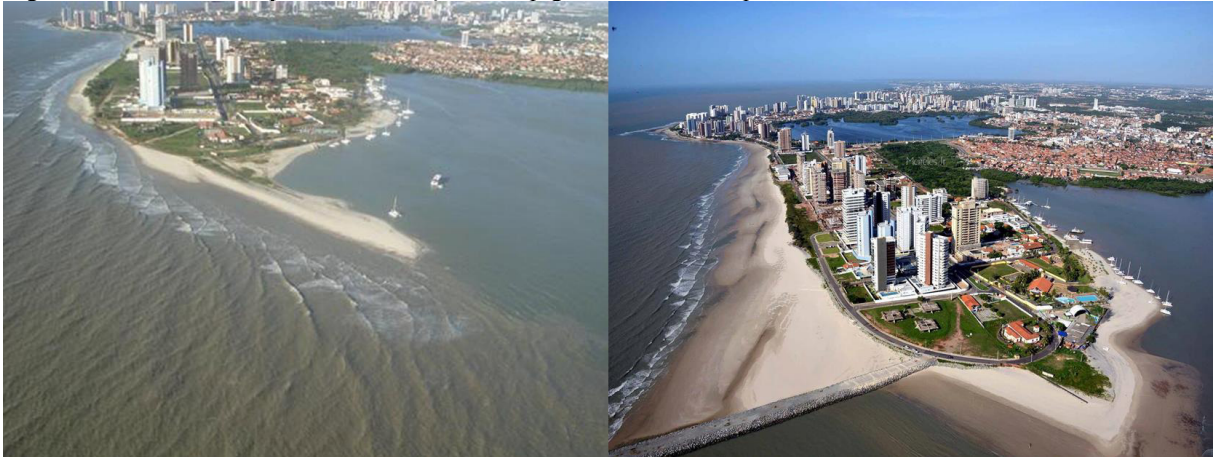
Figura 3- Foto antes e depois da construção do espigão costeiro no esporão arenoso da Praia da Ponta da Areia.
