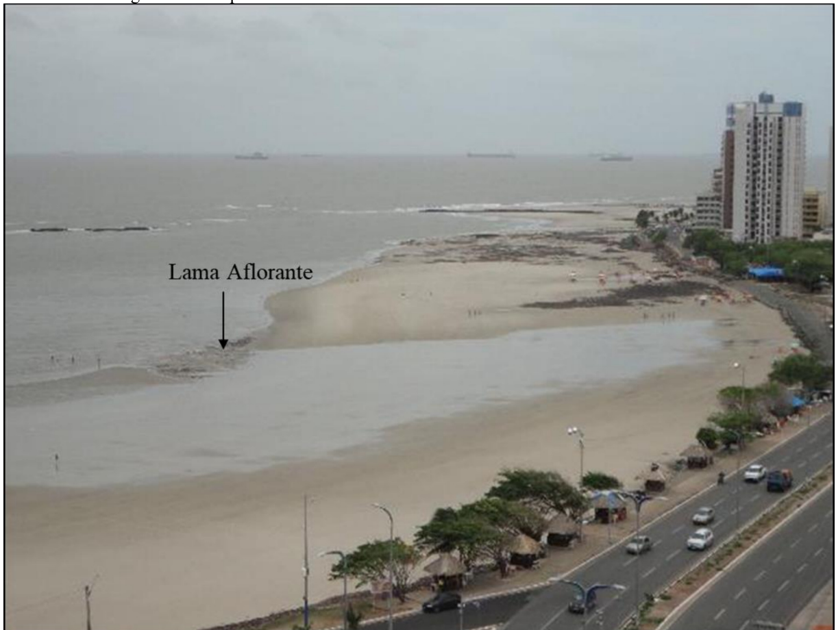
Figura 61- Foto da Praia da Ponta da Areia na região mais erosiva, com presença de lama aflorante e onde foi realizado a sondagem SV1 e o perfil P4.
