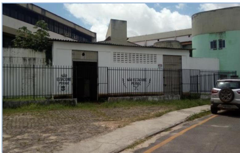
Figura 4.6 - Subestação do CCET
