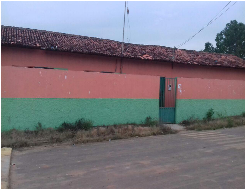
Figura 7 - Estado atual da Unidade Integrada Hipólito da Costa.
