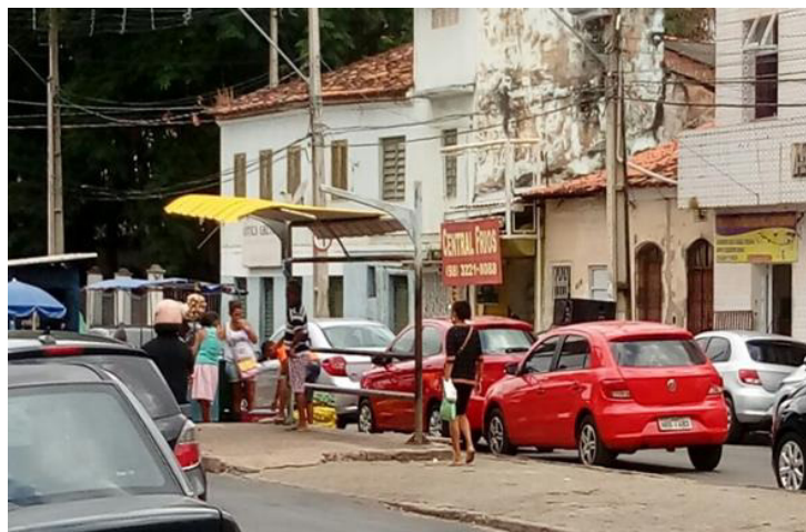
Figura 11- Detalhe da parada de ônibus sem qualquer proteção e assentos. Fonte: Autora, outubro de 2017
