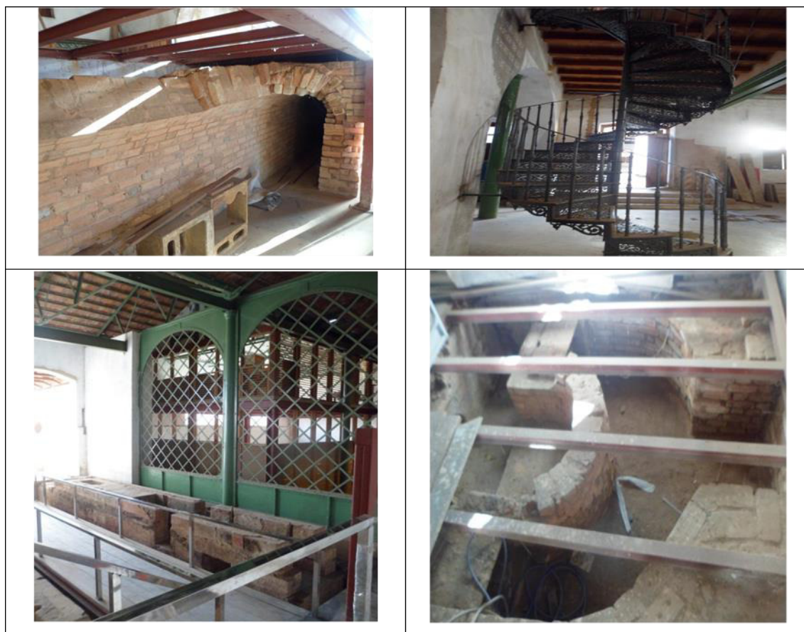
Figura 3- Achados durante a escavação: parte da chaminé, escada helicoidal (restaurada), bases de motores Fonte: Arquivo pessoal
