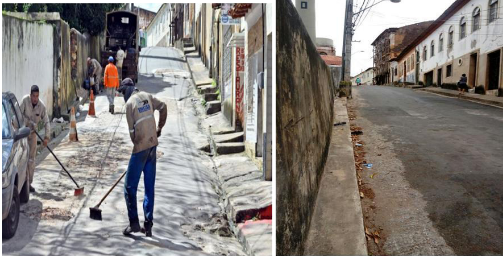
Figura 17- Rua da Inveja sendo asfaltada por trabalhadores (à esquerda) e concluída (à direita). Fonte: O Imparcial / (Autora, outubro de 2017)
