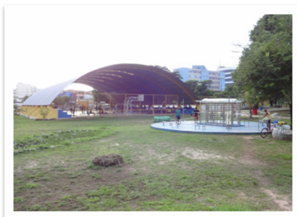
Figura 8 – Quadra coberta e estação de alongamento
