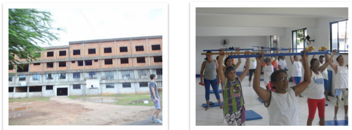
Figura 15 – Vista frontal do prédio do Polo Josué de Castro e atividades do programa em seu interior
