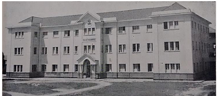
Figura 28 Colégio Maranhense, possuindo os ângulos retos da modernidade e os amplos telhados da tradição. (JORGE, 1950).
