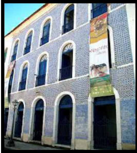
Figura 3 - Fachada da Casa de Nhozinho
