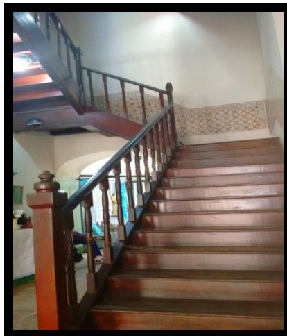
Figura 10 - Escadaria interna do prédio onde funciona a Casa da Fésta
