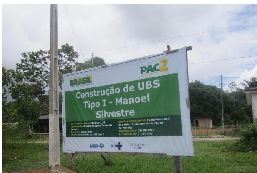
Figura 16: Placa de identificação da obra de construção de UBS na comunidade Santa Tereza.
