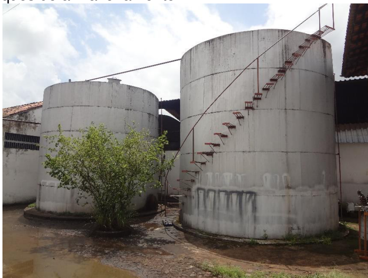
Figura 54 - Tanques de armazenamento
