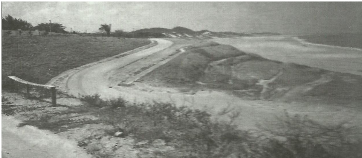
Figura 21 – Fotografia da construção da Avenida Litorânea, acesso à rotatória do Calhau.
