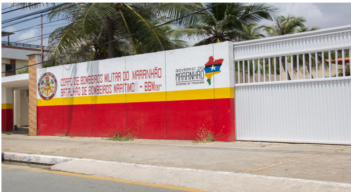
Figura 62 – Sede do Batalhão de Bombeiros Marítimo – BBMar – na praia do Calhau.
