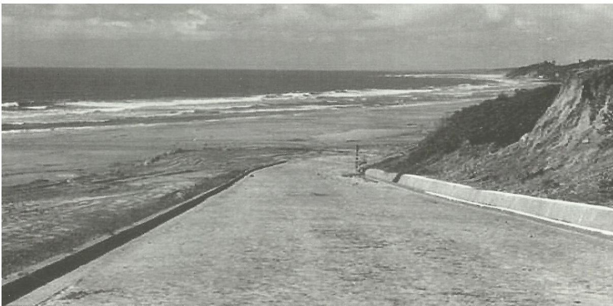
Figura 20 – Fotografia da construção da Avenida Litorânea, acesso à praia do Calhau.
