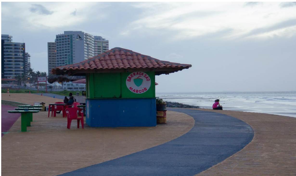
Figura 36 – Vista parcial da praia de São Marcos, com quiosques no calçadão.
