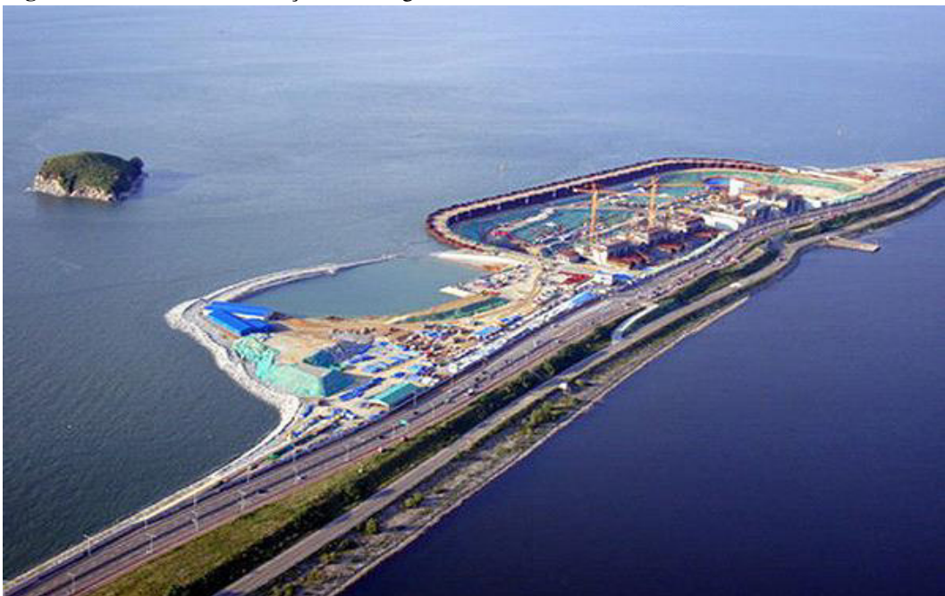
Figura 7 – Foto aérea da Estação de Energia Lake Sihwa
