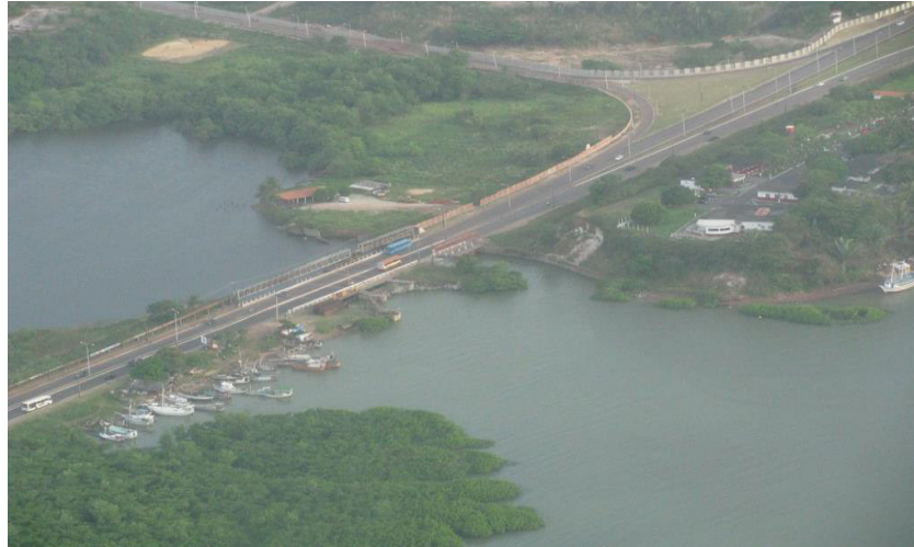
Figura 19 – Imagem da Barragem do Bacanga, em São Luís/MA
