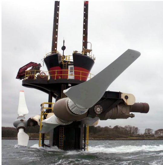
Figura 9 – Turbina de corrente marinha do tipo eixo horizontal
