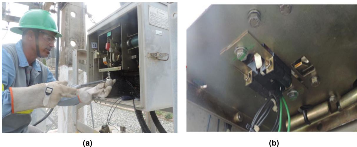
Figura 35: Fixação da chave fim de curso do religador com torquímetro (a) e aperto da chave concluído (b).
