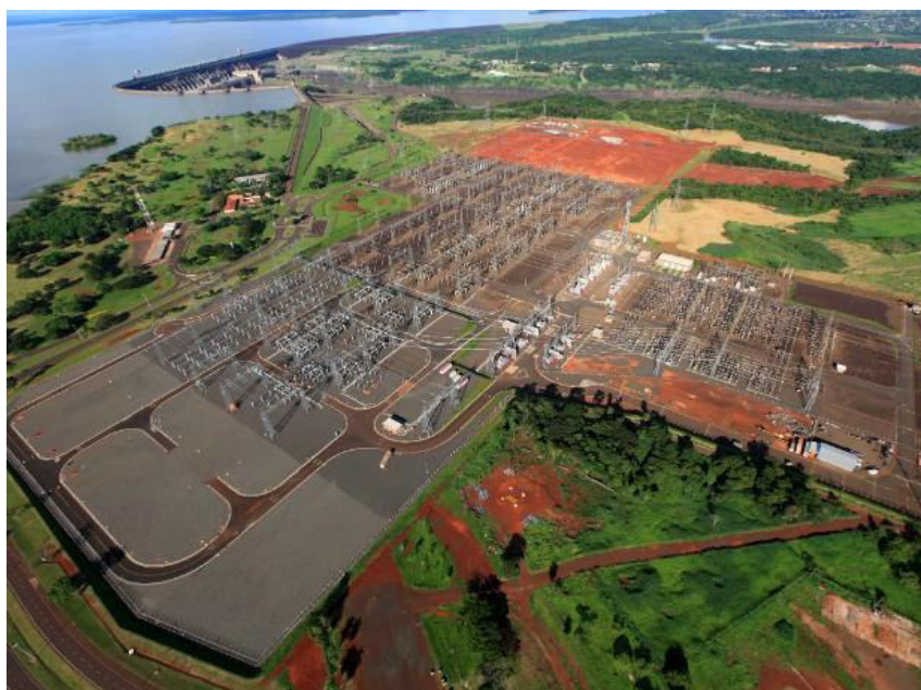
Figura 3.7: Subestação de extra alta tensão.
