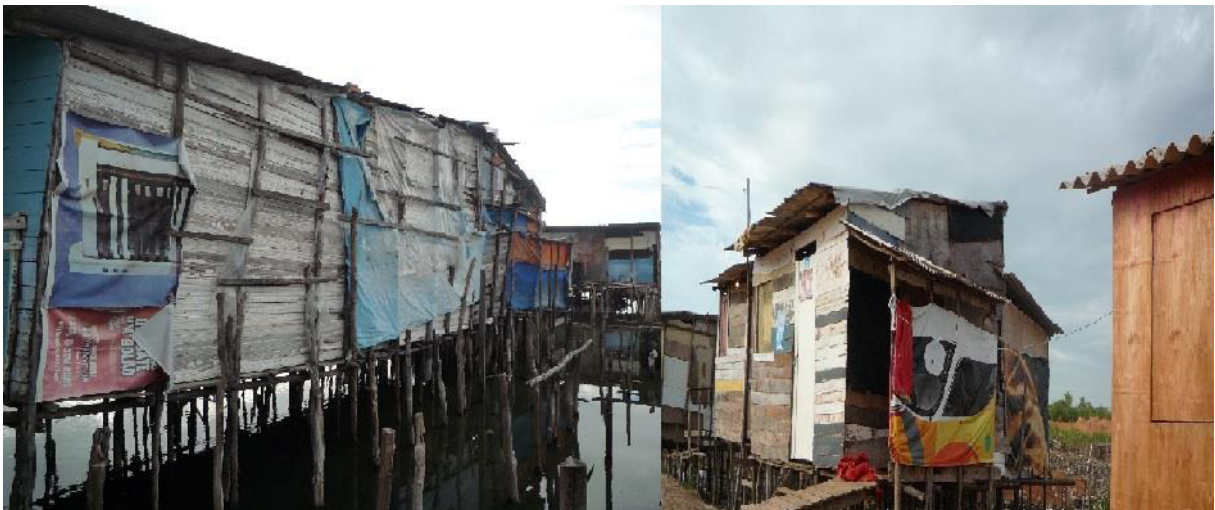
Figura 8: Palafitas com paredes de tábua, lonas e madeirite e cobertura de telha “brasilit”.
