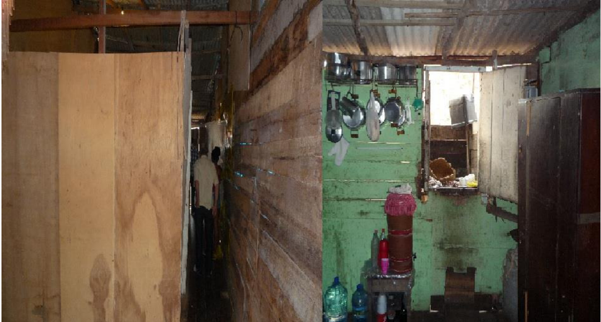
Figura 9- Divisões feitas por madeirite (esquerda) e jirau no fundo da cozinha (direita).
