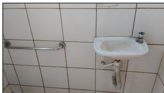
Imagem 8: Pia do banheiro feminino no Terminal Cohama/Vinhais: área interna do banheiro feminino adaptado para pessoas com deficiência física. Foto: SANTOS, D. S. 2016.
