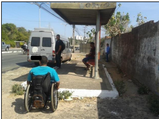
Imagem 26: Parada de ônibus sem acessibilidade. Cadeirante na parada de ônibus com cobertura, mas não existe rampa de acesso para que este chegue até a parte coberta. Foto: SANTOS, D. S, 2016.
