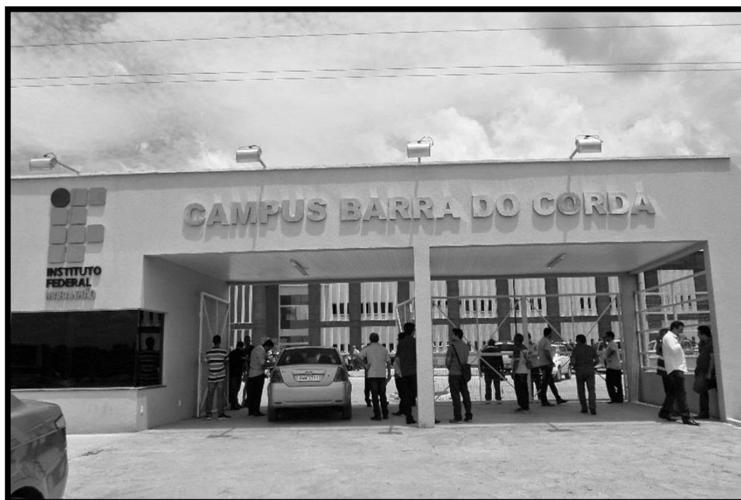
Imagem 29 - Entrada do IFMA Campus Barra do Corda Inaugurado em 2015. Fonte: Internet 21
