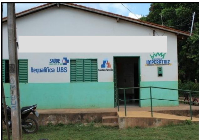
Figura 3- Rampa de acesso com corrimão, área externa da UBS-A*.Imperatriz, 2012.
