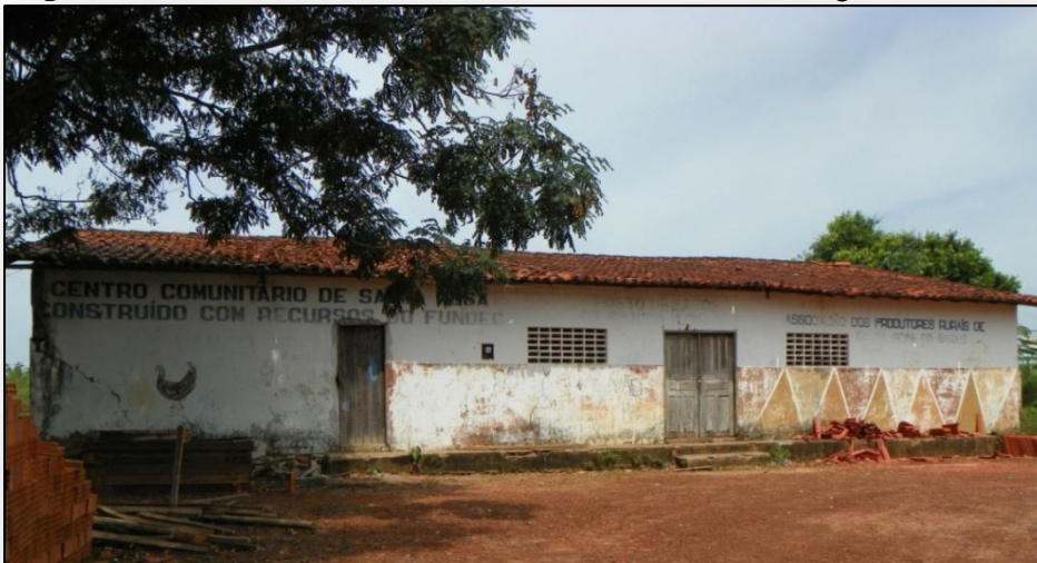
Figura 5 – Escola Mamãe Olivia (local onde funcionava a antiga creche da comunidade).
