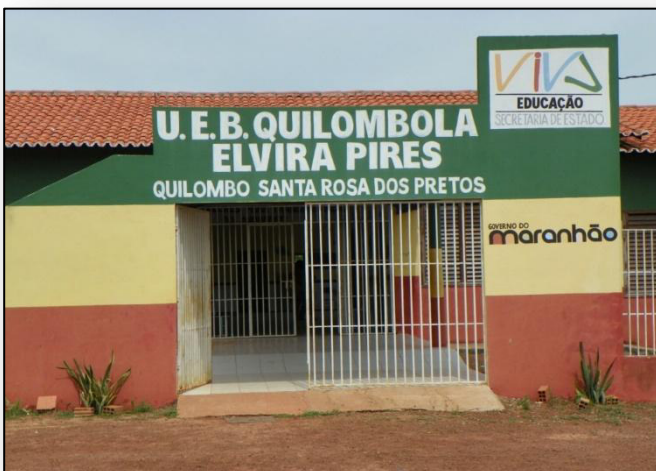
Figura 7 – Unidade de Educação Básica Quilombola Elvira Pires (prédio atual).
