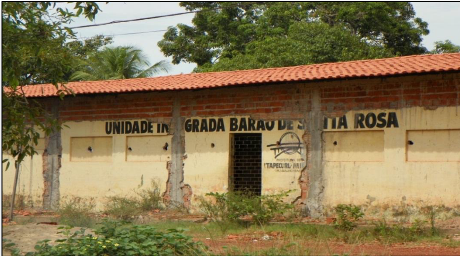
Figura 6 – Unidade Integrada Barão de Santa Rosa (o antigo prédio).
