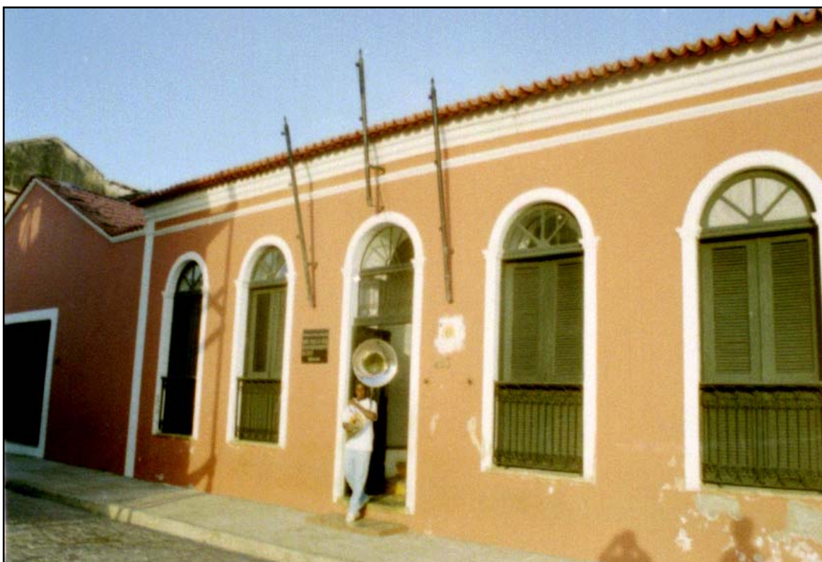
Foto 1 - Vista de frente o prédio onde funciona a escola de música Fonte: “in loco”
