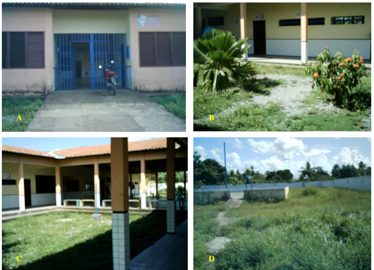
FIGURA 5.14 – Escola “Unidade Integrada Professora Santinha” (Bacuri-MA): A – Vista da fachada; B e C – Área interna; D – Área externa.
