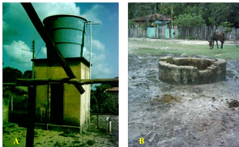
FIGURA 5.45 – Poços de abastecimento (Bacuri/MA): A – Artesiano da CAEMA em Pequizeiro; B – Tipo cacimba, domínio público, no centro da sede municipal de Bacuri.
