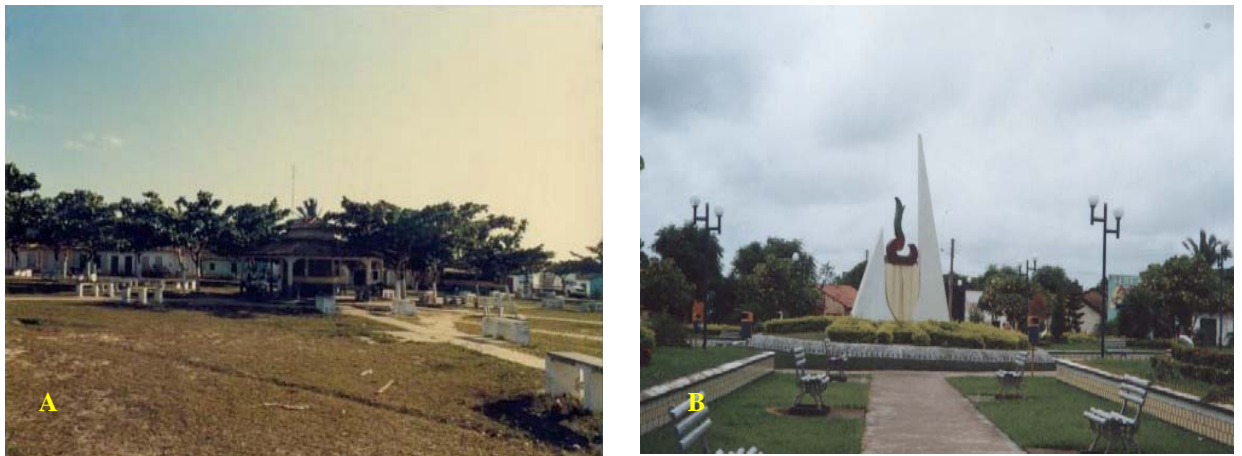
FIGURA 5.41 – Praça de Bacuri: A – antes da reforma; B – após a reforma.
