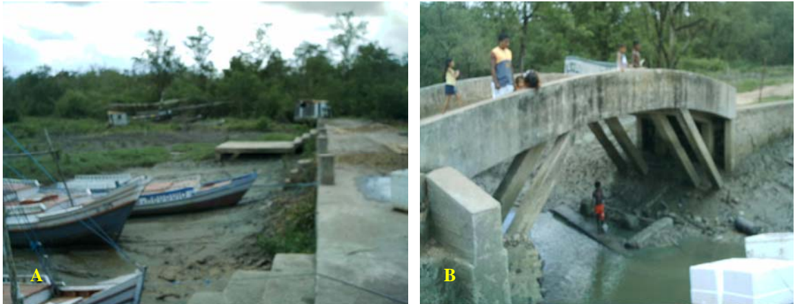
FIGURA 5.33 – Área do Porto do Campinho: A – Cais com estrutura de acesso para embarque e desembarque de passageiros; B – Ponte que liga ao Bairro do Campinho.
