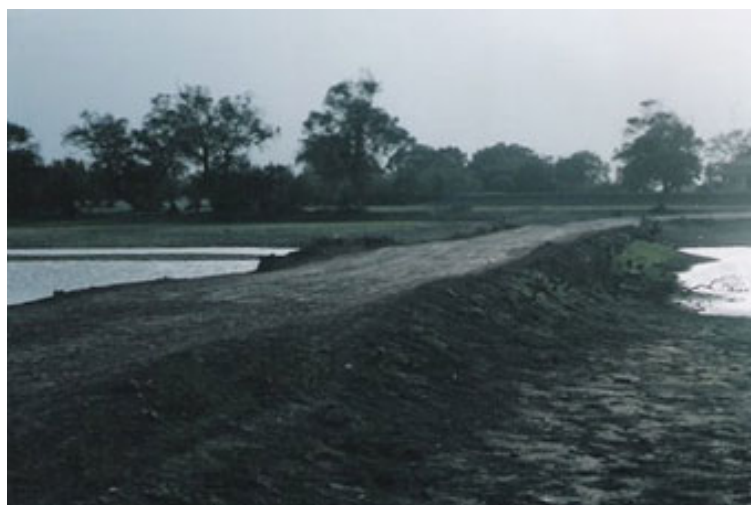
FIGURA 19: Fotografia da Barragem da Colhereira
