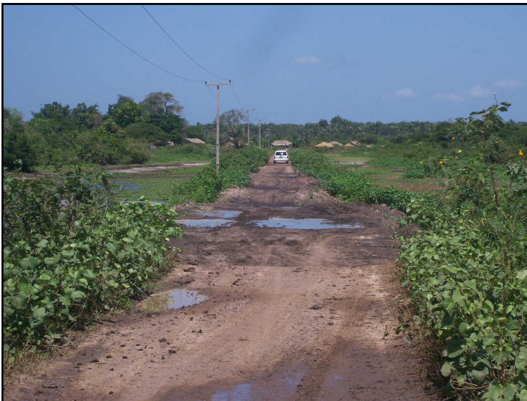
FIGURA 4.9 - Barragem sobre o igarapé do Baiano – inundação em declínio.
