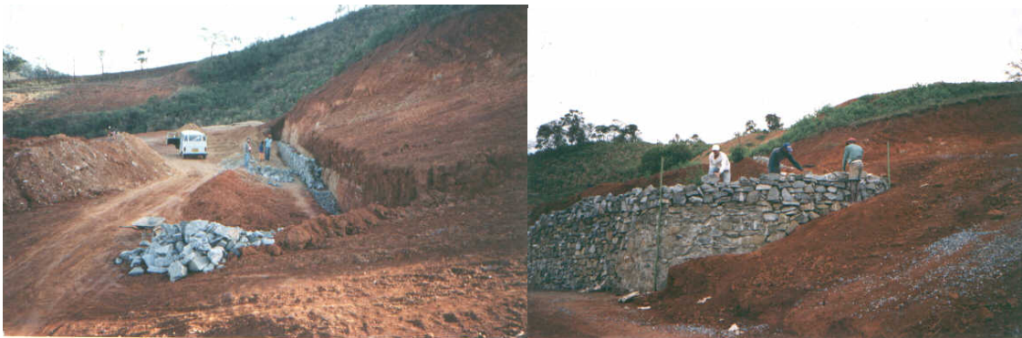
FIGURA 34 – Área recuperação com técnicas tradicionais - muro de arrimo
