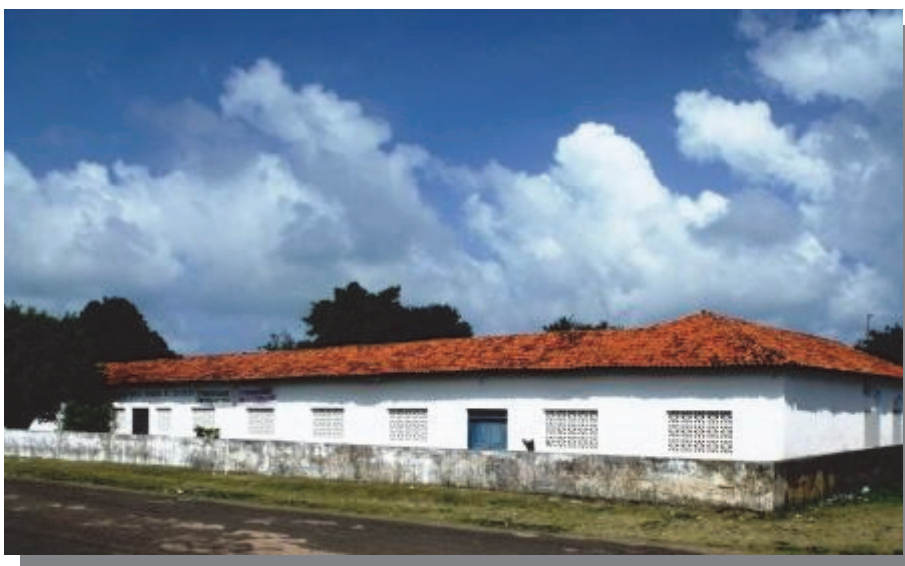
Prédio da Unidade Escolar Nossa Senhora da Assunção
