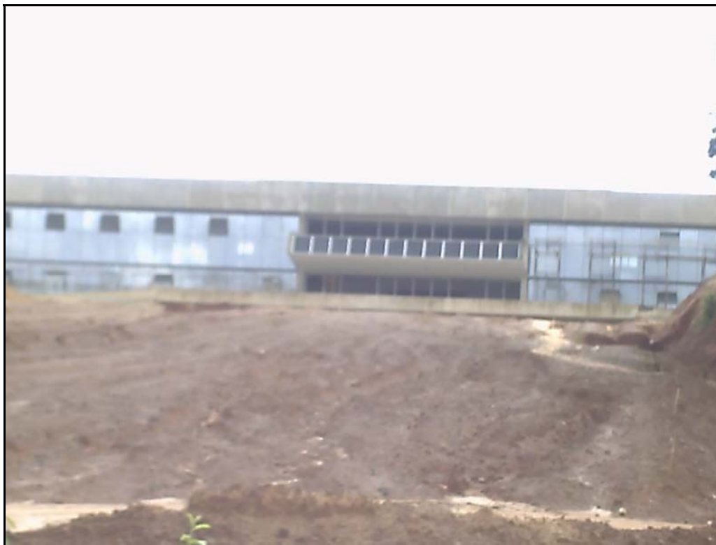
FIGURA 17: Vista das futuras instalações da Assembléia Legislativa do Estado do Maranhão dentro do perímetro da Estação Ecológica do Rangedor. Fonte: O autor da pesquisa.
