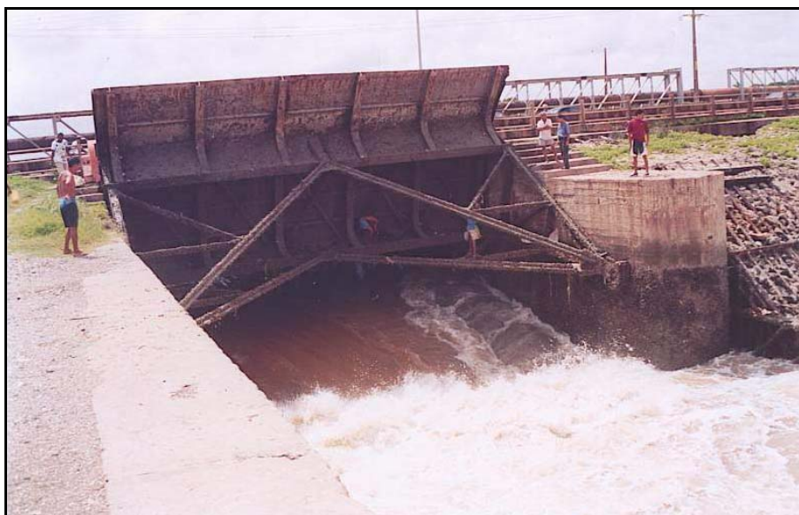
FIGURA 8: Comporta aberta da barragem. (Fonte: RHANSAR, 2007)
