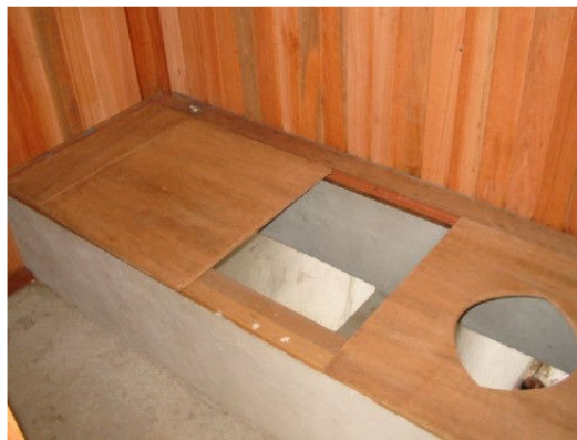
Figura 21b: Etapas de construção de um banheiro seco com duas câmaras em Siderópolis (SC). A-Capeamento de laje de piso do abrigo e aplicação de chapisco na alvenaria.B- Construção de abrigo em madeira. G- Banheiro seco concluído.H- Vista local do futuro assento (direita) e espaço para compartimento para armazenamento de serragem (SETE LOMBAS, 2009).
