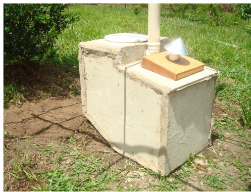
Figura 18b: Montagem da câmara de compostagem. A- Vista interna do Bason com manivela; B- Bason concluído com acessórios.
