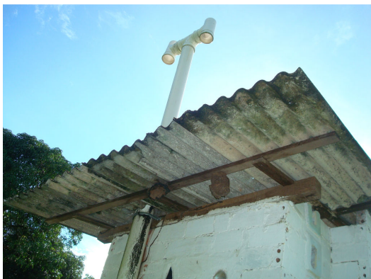
Figura 7a: Registro fotográfico do banheiro seco construído na comunidade de Maracanã em São Luís –MA: A- Vista diagonal direita do banheiro seco; B- Vista interna do banheiro seco com garrafas pet utilizadas na iluminação natural do ambiente; C- Vista saída da tubulação de exaustão; D- Vista inferior da laje de piso do banheiro seco.
