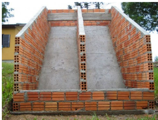
Figura 21a: Etapas de construção de um banheiro seco com duas câmaras em Siderópolis (SC). A- Elevação da alvenaria base para laje de piso do abrigo; B- Disposição de laje de piso do abrigo. C- Preparação de rampa de descida dos dejetos com laje pré-fabricada. D- Revestimento da rampa e elevação da alvenaria das câmaras de compostagem
