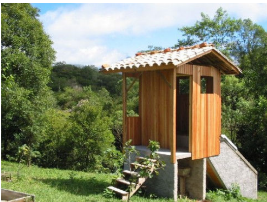
Figura 21b: Etapas de construção de um banheiro seco com duas câmaras em Siderópolis (SC). A-Capeamento de laje de piso do abrigo e aplicação de chapisco na alvenaria.B- Construção de abrigo em madeira. G- Banheiro seco concluído.H- Vista local do futuro assento (direita) e espaço para compartimento para armazenamento de serragem (SETE LOMBAS, 2009).
