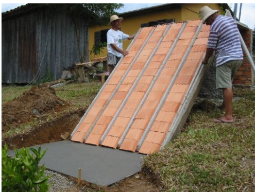
Figura 21a: Etapas de construção de um banheiro seco com duas câmaras em Siderópolis (SC). A- Elevação da alvenaria base para laje de piso do abrigo; B- Disposição de laje de piso do abrigo. C- Preparação de rampa de descida dos dejetos com laje pré-fabricada. D- Revestimento da rampa e elevação da alvenaria das câmaras de compostagem
