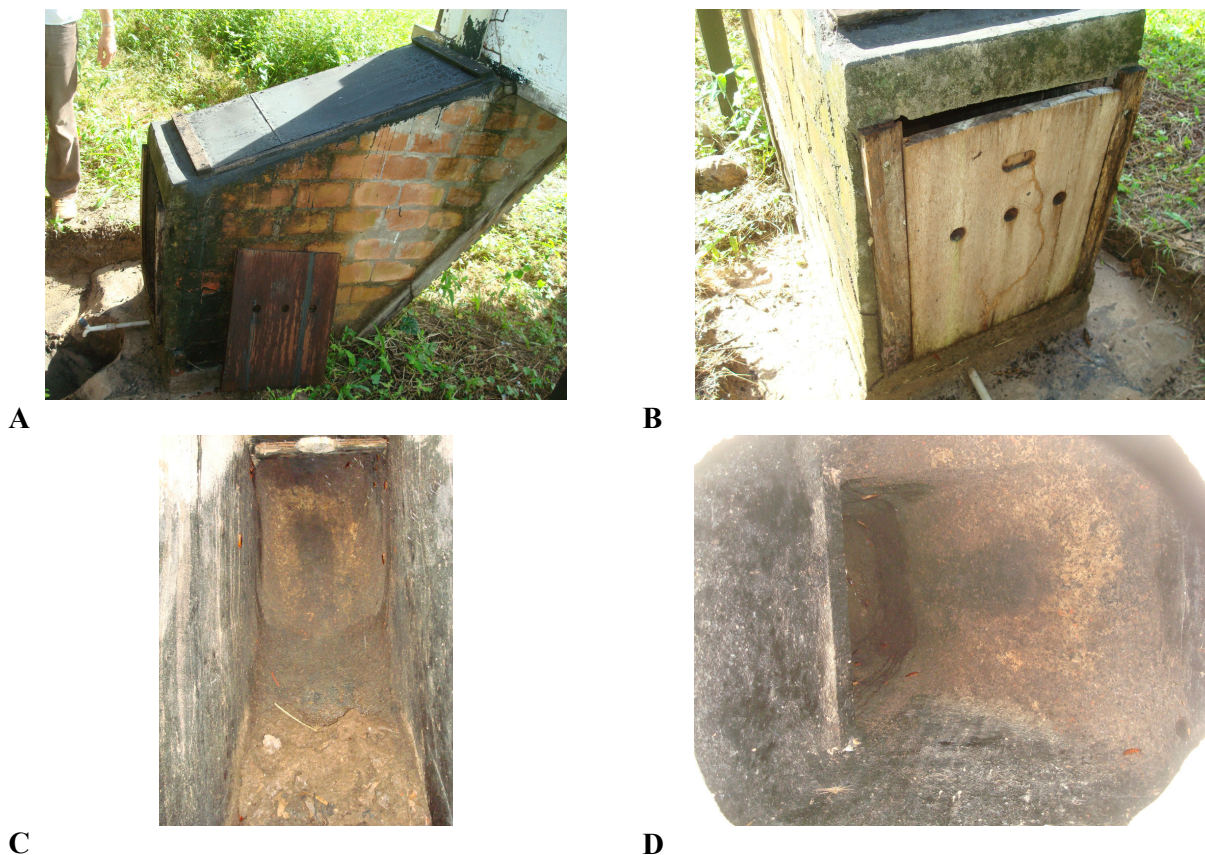
Figura 7b: Registro fotográfico do banheiro seco construído na comunidade de Maracanã em São Luís: A- Vista externa da câmara de compostagem; B- Portinhola de madeira tipo guilhotina na saída da câmara compostagem. C- Vista interna câmara de compostagem. Presença de insetos; D- Vista interna superior da câmara de compostagem. Presença de insetos.
