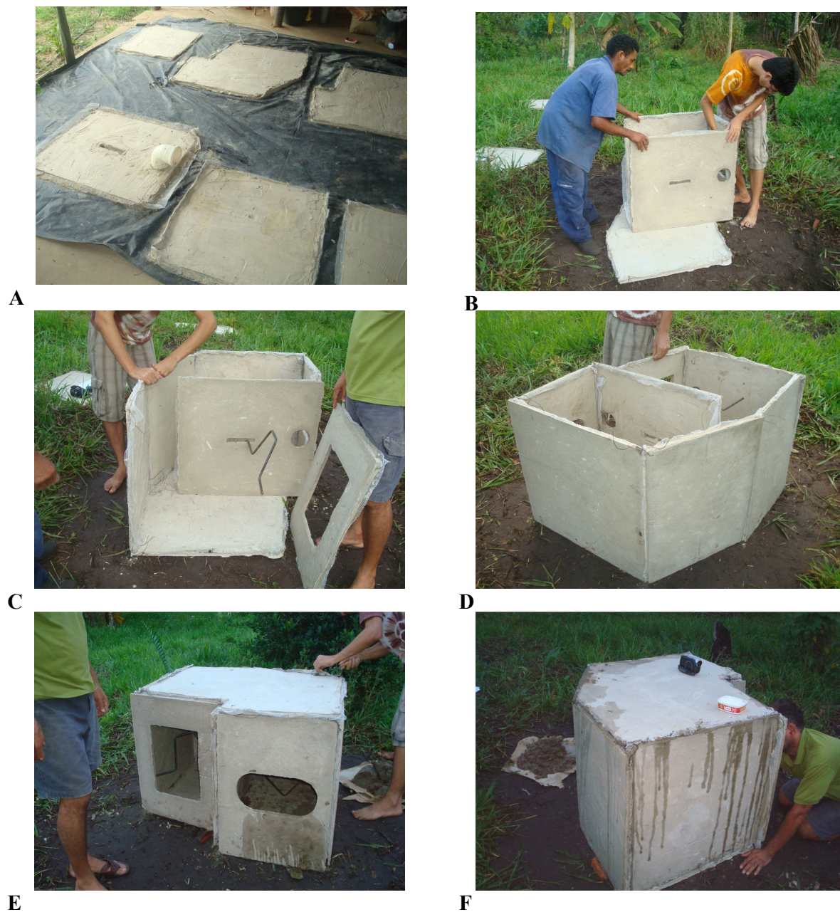
Figura 18a: Montagem da câmara de compostagem. A- Placas curadas antes da utilização; B- Início da montagem das placas; C- Montagem das placas com colocação da manivela para aeração; D- Câmara parcialmente montada ; E- Bason com placas de plastocimento encaixadas; F- Início de argamassamento das placas;
