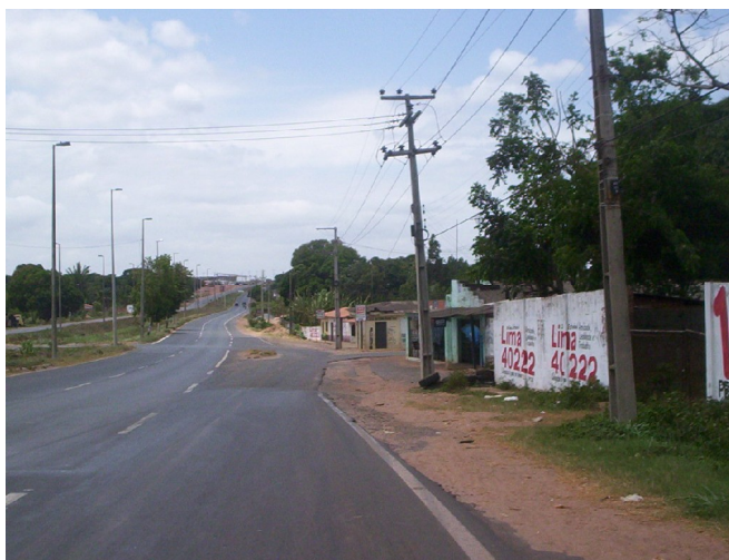
Figura 7 – BR-135 - Estrada de Acesso ao Maracanã Fonte: CHAVES, 2006.
